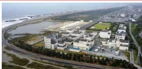
浜松市西遠浄化センター
