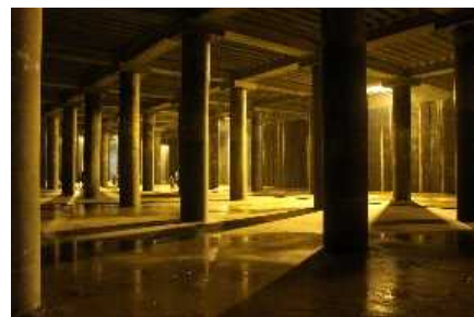
貯留施設(福岡市)
