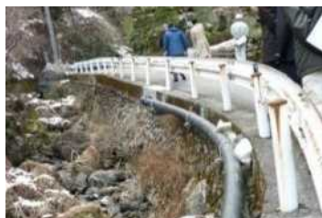
クイック配管 (露出配管)
