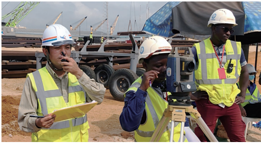
写真-1 現場測量状況
